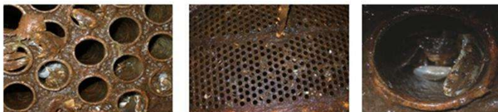
Рис. 2. Трубки конденсаторов турбины Казанской ТЭЦ-1 после промывки, забитые моллюском дрейсены
